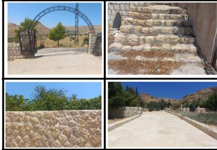
Şekil 12. Süryani Mezarlığı; merdiven, sınır duvarı mevcut yol, giriş kapısı görselleri.
