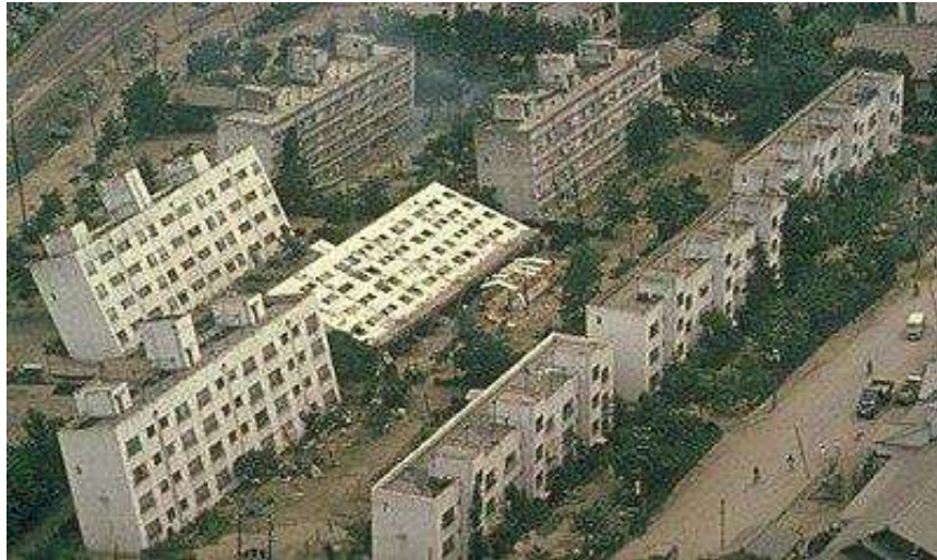
Şekil 1. 1964 Niigata Depremi Sonrası
